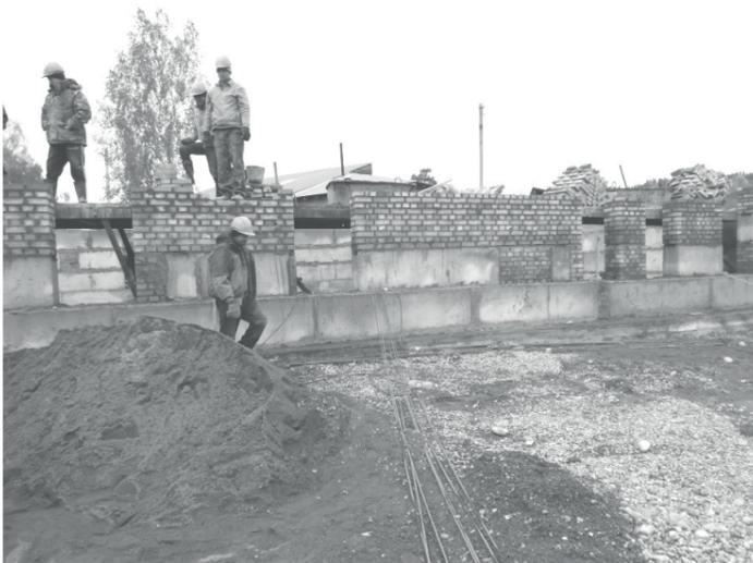
Полным ходом ведётся строительство нового корпуса Турочакской школы. На данный момент идут работы по укладке фундамента, затем он будет гидроизолирован и утеплён, засыпан, после чего начнётся строительство стен здания.
