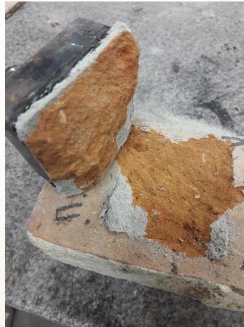
Поверхности рядового кирпича и испытательного штампа, свидетельствующие об отрыве штукатурки по телу материала основания
