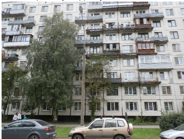
ул. Брянцева д.2, корп.2, литера А лицевой фасад. Серия 1ЛГ-606
