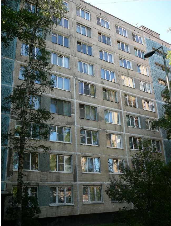
Дом до проведения капитального ремонта фасада
