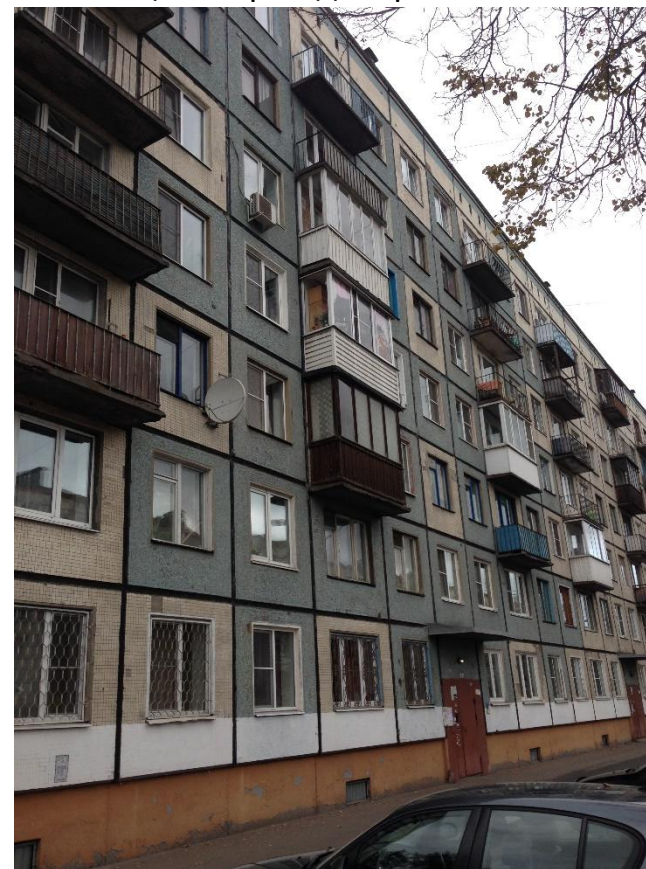
пр. Металлистов д.50, литера А лицевой фасад. Серия 1ЛГ-507
