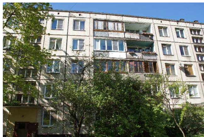
ул. Бухарестская д.23, корп.2 лицевой фасад. Серия 1ЛГ-504
