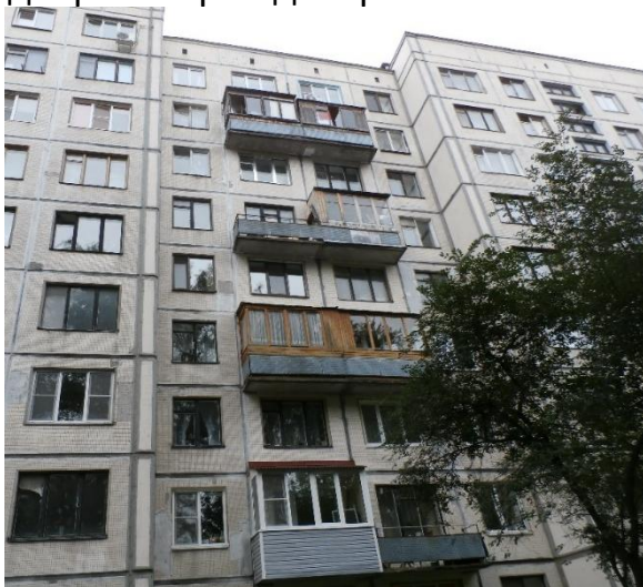
ул. Брянцева д.2, корп.2, литера А дворовой фасад. Серия 1ЛГ-606
