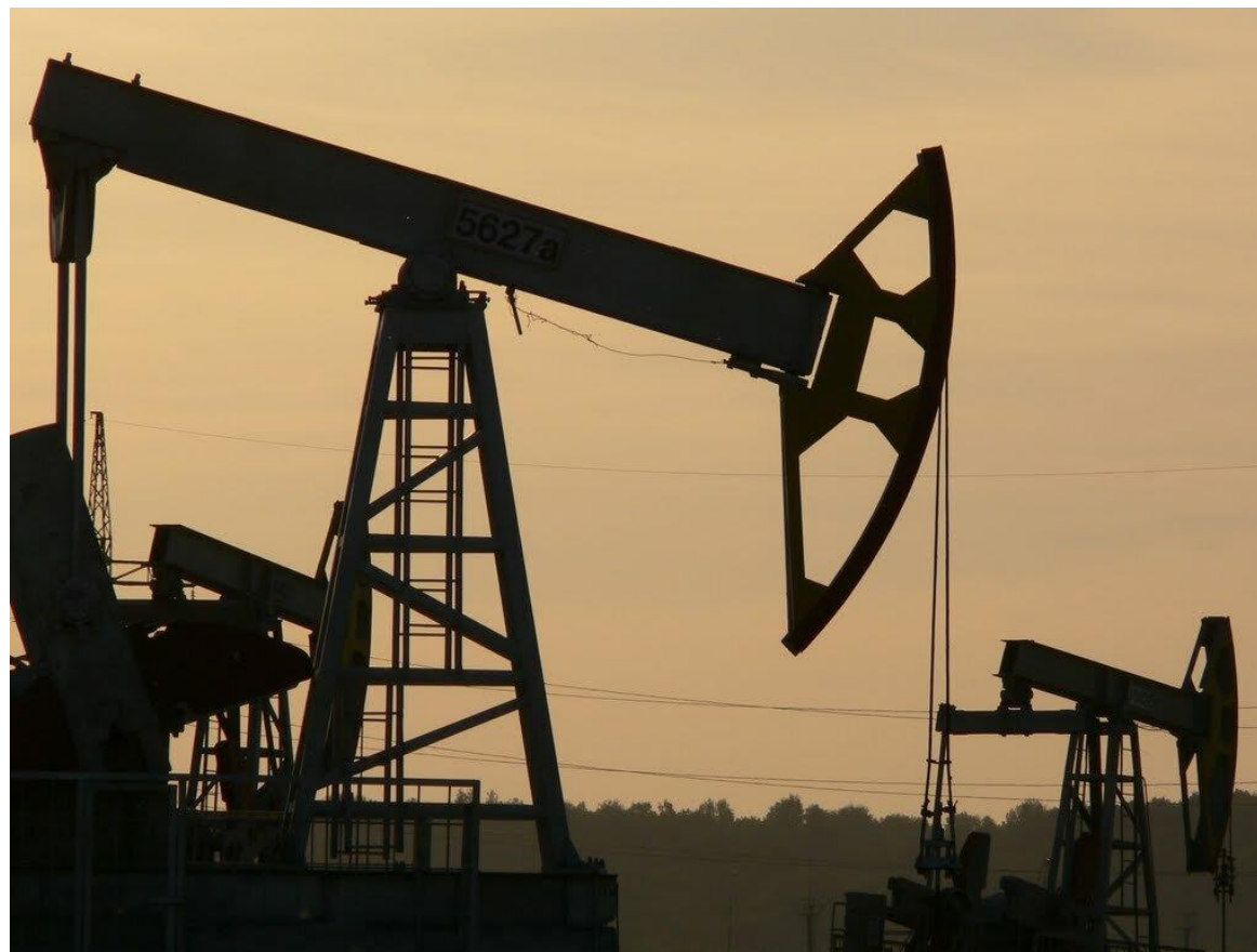
Станки-качалки (замена асинхронных приводов)
