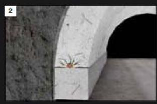
На базе нового строительства проектирование инжект-системы для оперативного ремонта и уплотнения швов ремонтными материалами в случае образования фильтрации воды в процессе эксплуатации конструкции.
