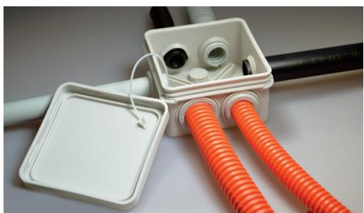
В подготовленные отверстия распаячной коробки установить трубы с выбранным диаметром.
