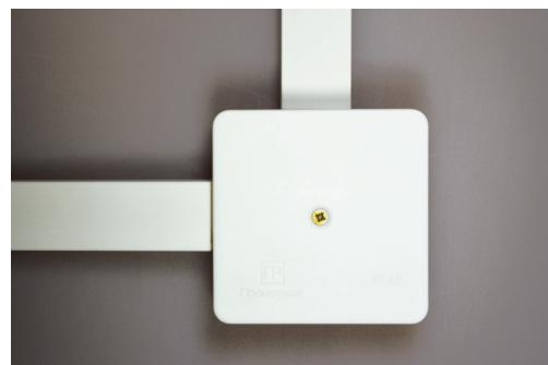
Установите крышку в корпус и закрутите винтом.
