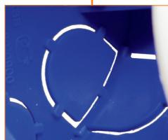
Двенадцать перфорированных отверстий, позволяет подводить трубы 16, 20 диаметра.
