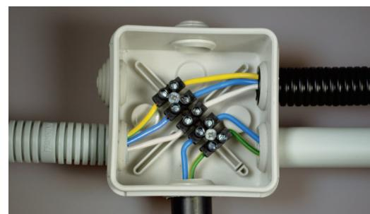
В трубы, установленные в распаячную коробку, проложите кабель. Закрепите кабель в установленные клеммы.
