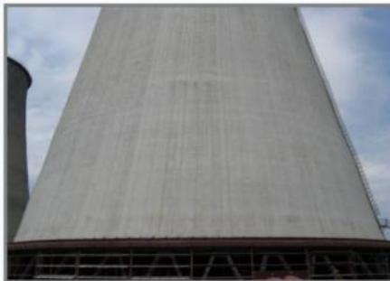
Защитное покрытие и гидроизоляция
