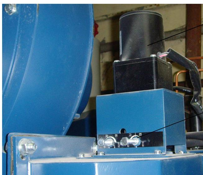
Двигатель воздушной заслонки
