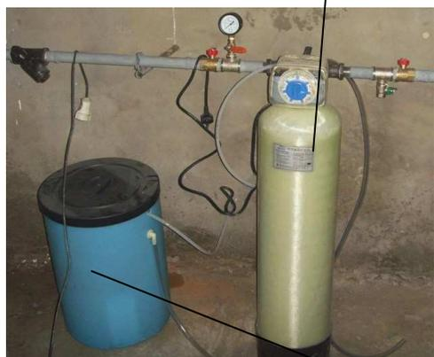
Это ионообменный фильтр, который представляет собой сосуд из армированного стекловолокна, заполненный слоями материала, называемого ионитом или ионообменной смолой, и обычно представляющим собой гранулы диаметром от 0,5 до 1,0 мм.
