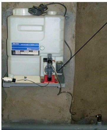
**Насос-дозатор**, установленный на баке с химреагентом, подает его в умягченную воду.
