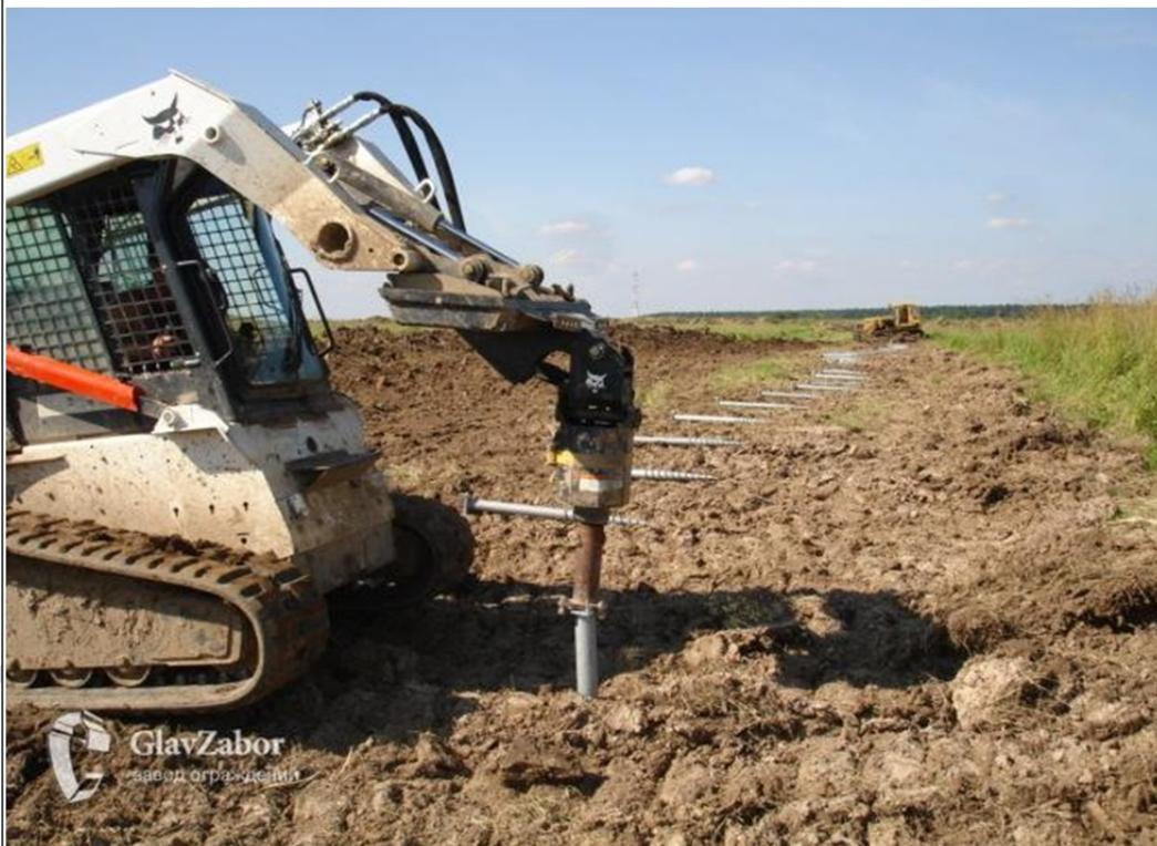
*Для одноэтажной постройки размером 6х6м. Достаточно 16 винтовых опор. При этом несущая нагрузка на фундамент составит 40 тонн.*
