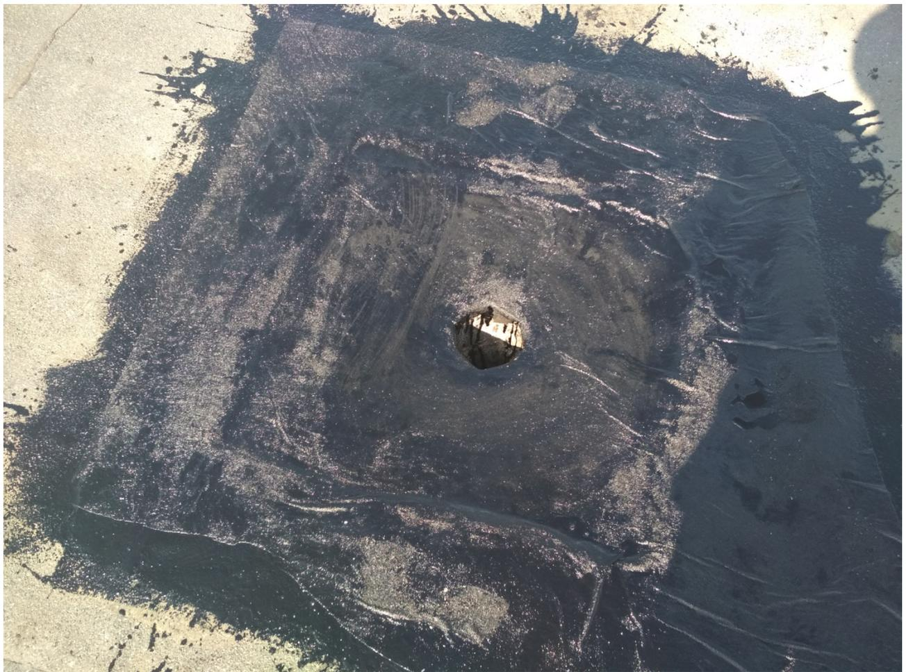
После обработки сложных участков производится нанесение сплошного слоя жидкой резины. Нанесение производить кистями, валиками. Допускается разглаживание слоя шпателями. Толщина сырого слоя не должна превышать 1,5 мм. Не производить ремонт наливом мастики в трещины и углубления!!!
