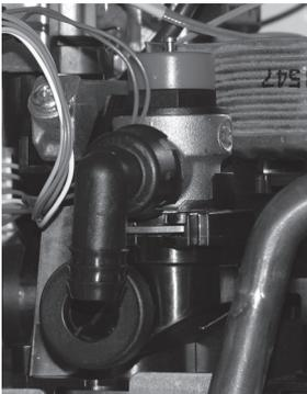
**Предупреждение:** Запрещается манипулировать с предохранительным клапаном во время работы котла. Кроме того, не разрешается использовать предохранительный клапан для слива воды из котла или системы отопления. На неисправности клапана, вызванные засорением шлаком из системы отопления, гарантия не распространяется.
