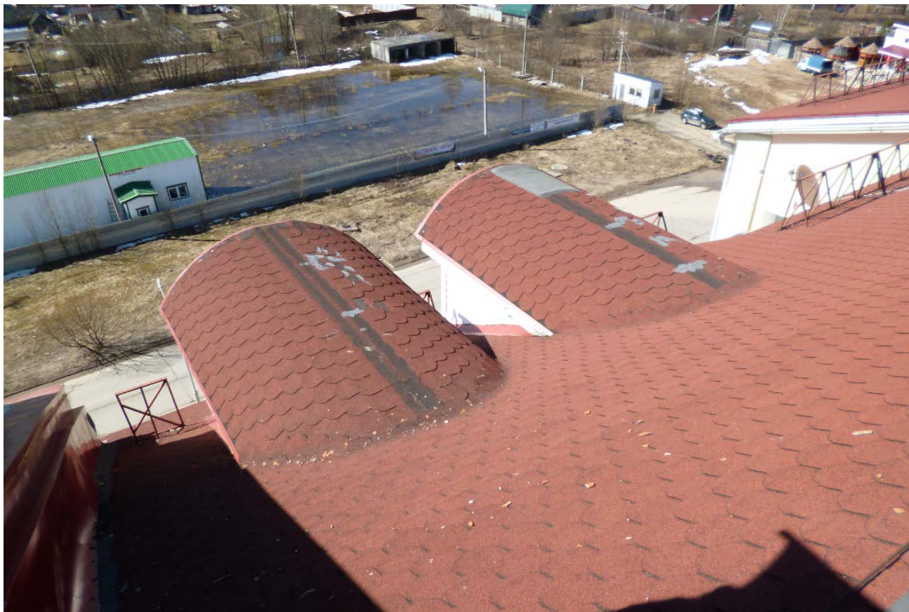
Фотофрагмент 13. Срывы отдельных элементов гибкой черепицы со сводчатых слуховых окон
