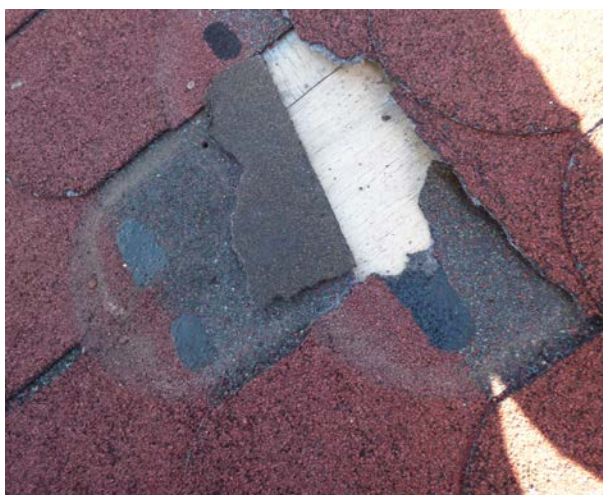
Фото Ф-10. а) Локальные отрывы элементов черепицы; б) локальный ремонт кровли рулонными материалами
