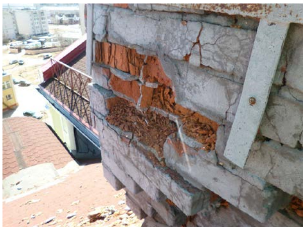
Фото Ф-15. Аварийное состояние кирпичной кладки вентиляционных каналов.
