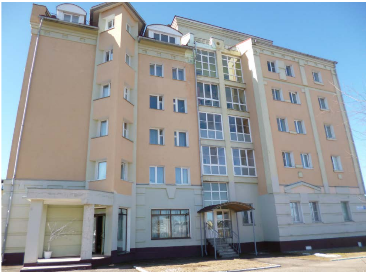
Фото Ф-5. Фасад в осях 1-А1
