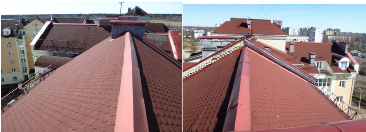
Фото Ф-9. Общий вид кровли
