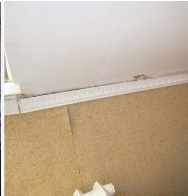
Фото Ф-17. Общий вид (б) и детальная фотофиксация (а) результатов протечек в помещении мансардного этажа под сводчатым слуховым окном
