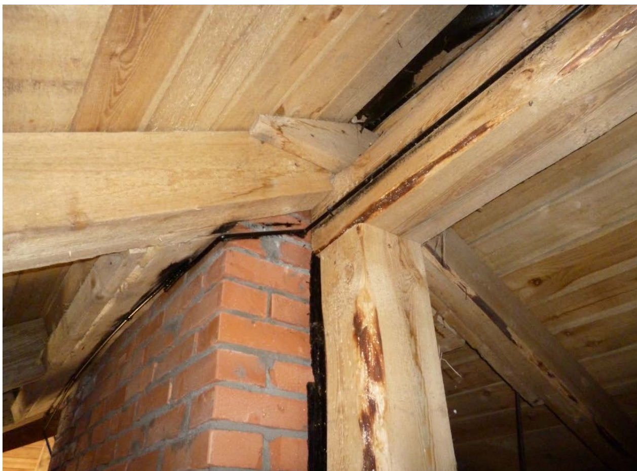
Фотофрагмент 16. Работоспособное состояние элементов стропильной системы, а также кладки вентиляционной шахты
