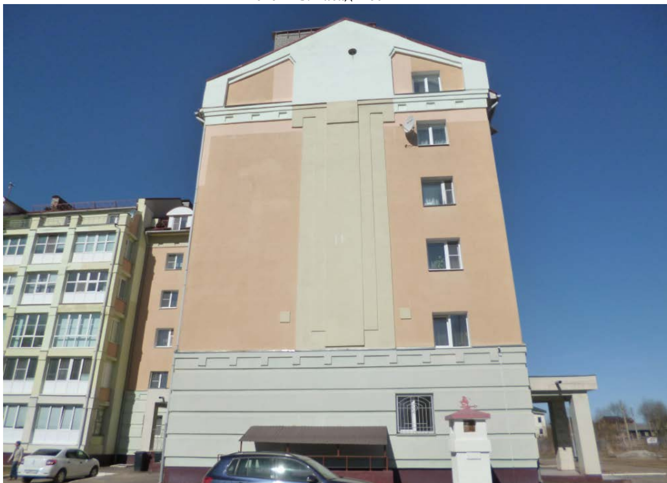
Фото Ф-6. Вид здания в осях 2-А
