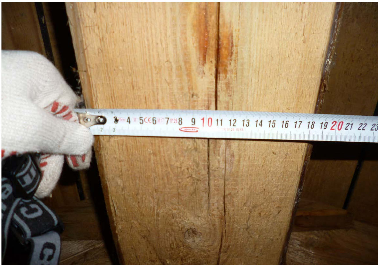
Фотофрагмент 20. Замеры фактического сечения стойки
