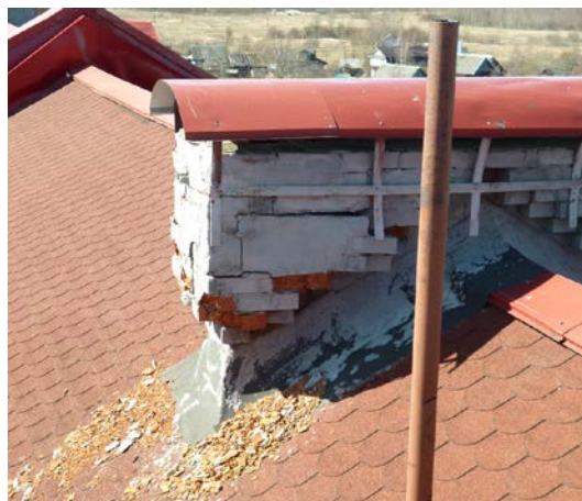
Фото Ф-15. Аварийное состояние кирпичной кладки вентиляционных каналов.
