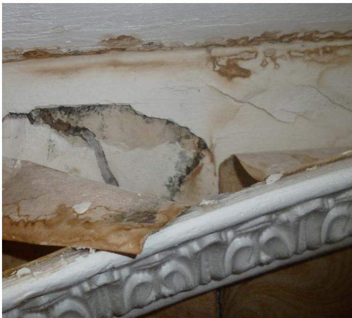
Фото Ф-17. Общий вид (б) и детальная фотофиксация (а) результатов протечек в помещении мансардного этажа под сводчатым слуховым окном
