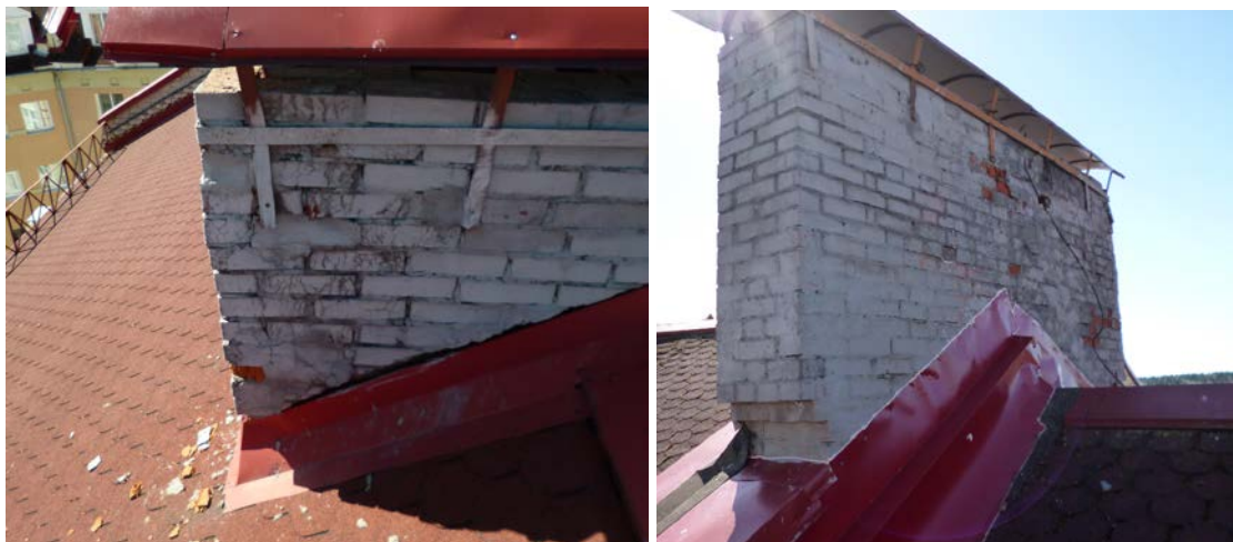
Фото Ф-16. Морозная деструкция различной степени.
