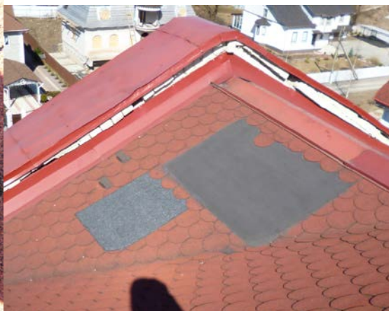
Фото Ф-10. а) Локальные отрывы элементов черепицы; б) локальный ремонт кровли рулонными материалами
