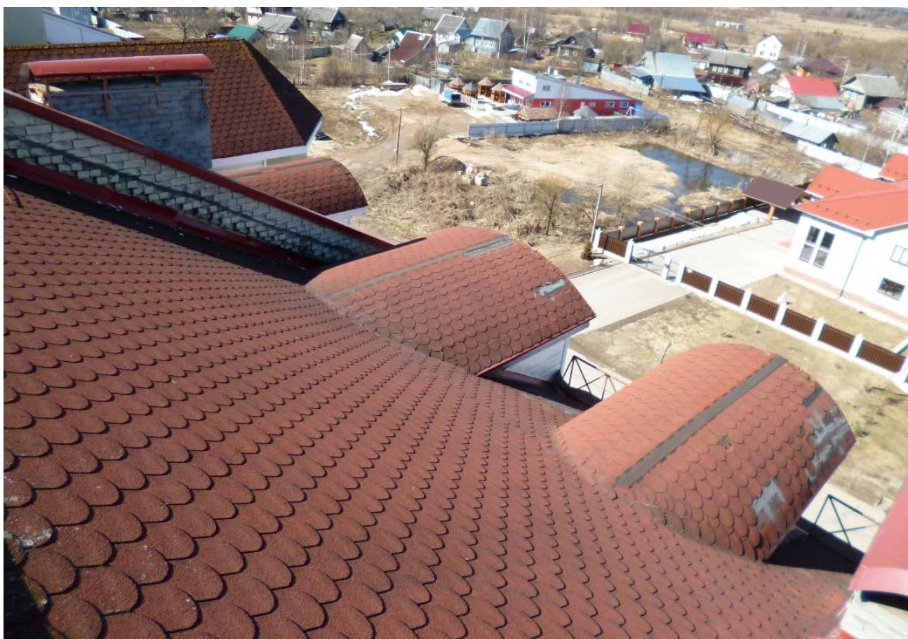
Фотофрагмент 10. Отрывы отдельных элементов черепицы со сводчатых слуховых окон
