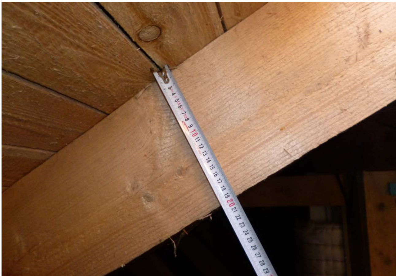
Фотофрагмент 19. Замеры фактического сечения стропильной ноги рядовой
