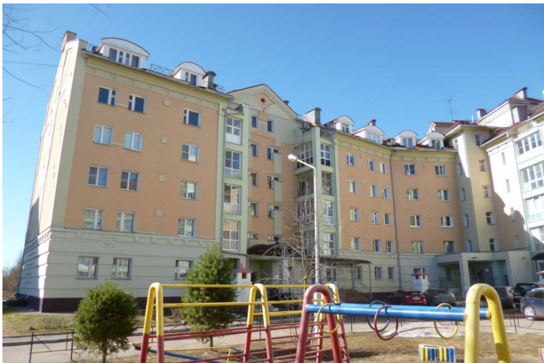
Фото Ф-1. Общий вид здания в осях 10-9
