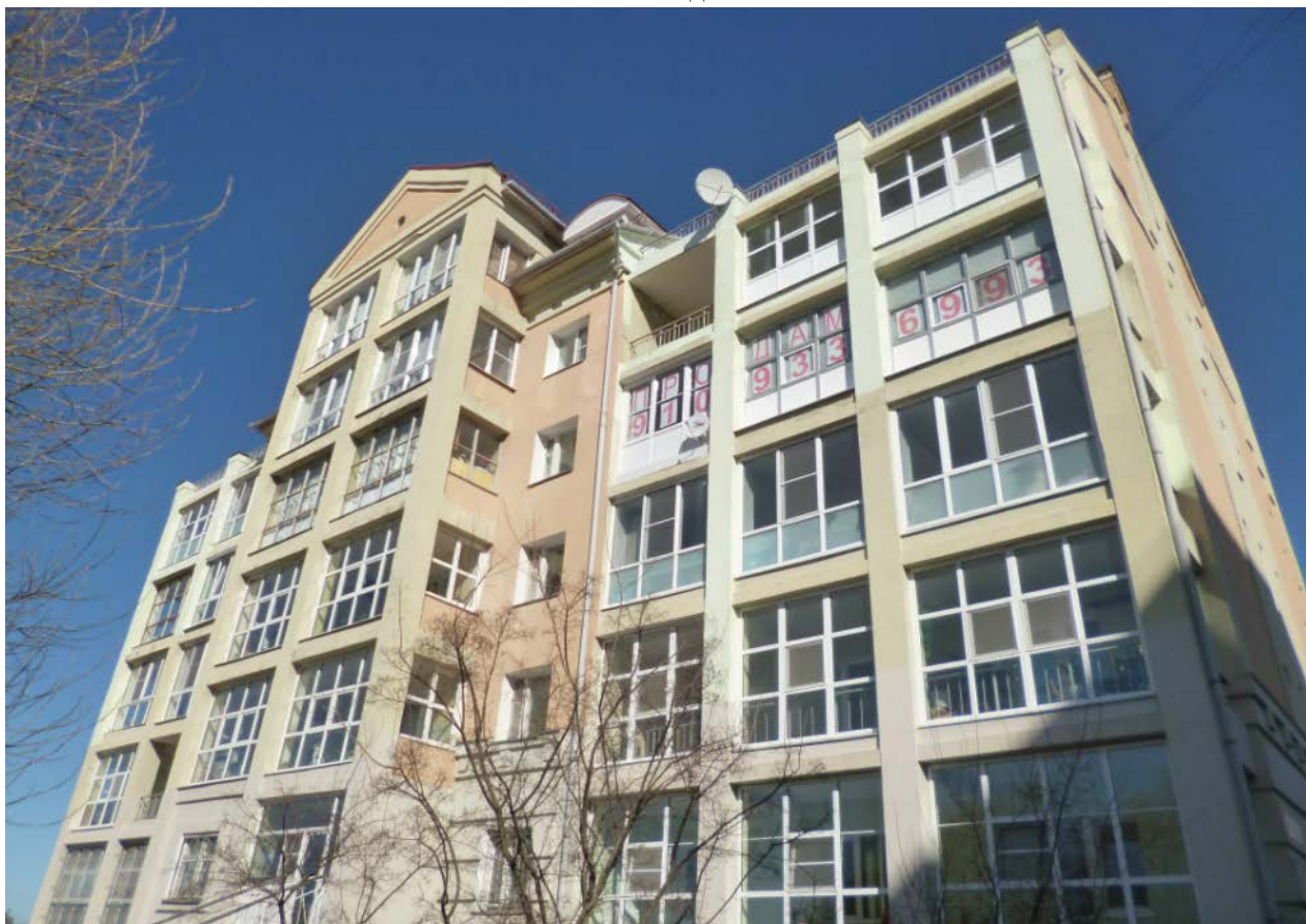
Фото Ф-4. Вид здания в осях 9-10
