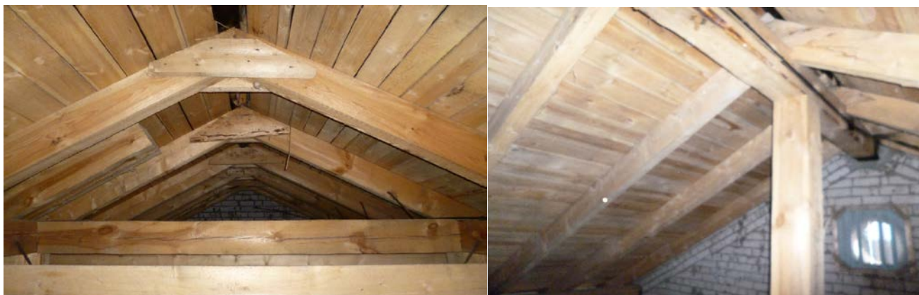
Фото Ф-7. Общий вид стропильной системы в зависимости от расположения в осях
