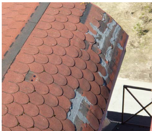
а) б) Фото Ф-11. а) Отрывы гибкой черепицы на сводчатых слуховых окнах
