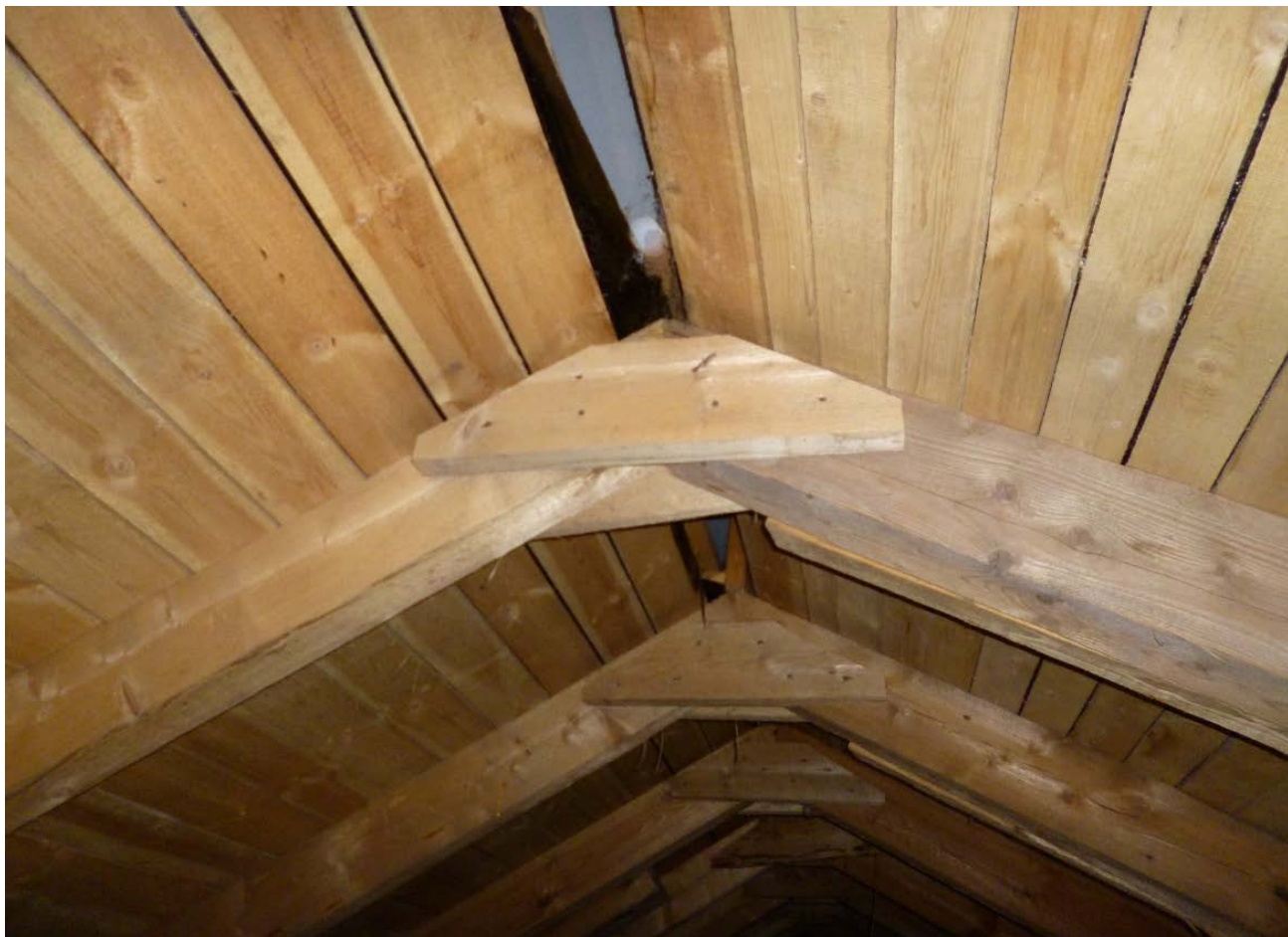
Фотофрагмент 17. Работоспособное состояние элементов стропильной системы
