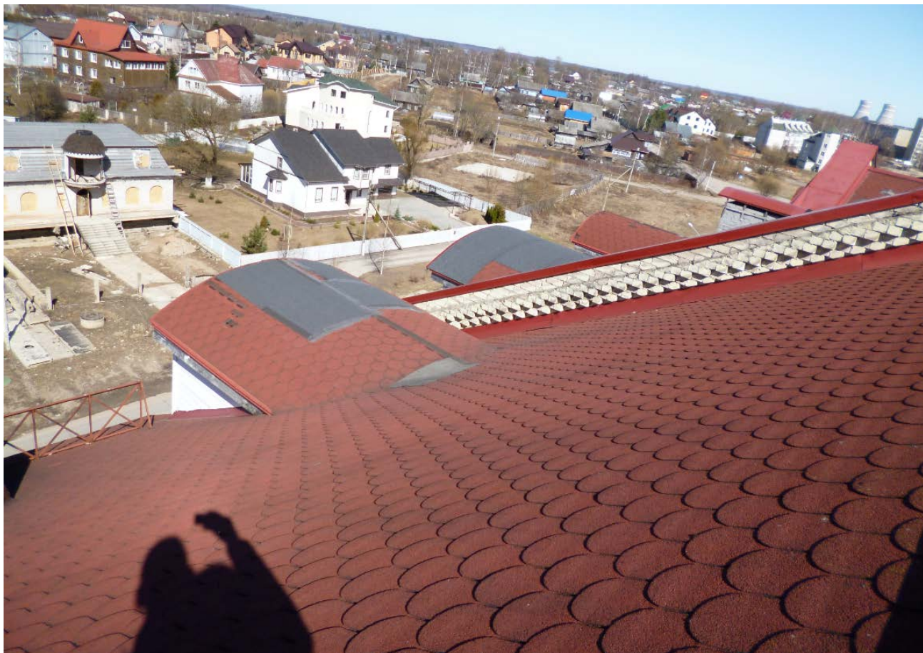
Фотофрагмент 9. Локальный ремонт кровельного ковра на сводчатых слуховых окнах
