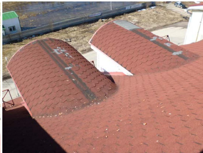
а) б) Фото Ф-11. а) Отрывы гибкой черепицы на сводчатых слуховых окнах
