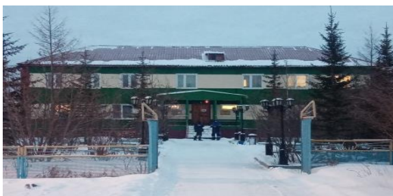
Рис. 14. Здание ООО «ПТВС» в городе Удачный
