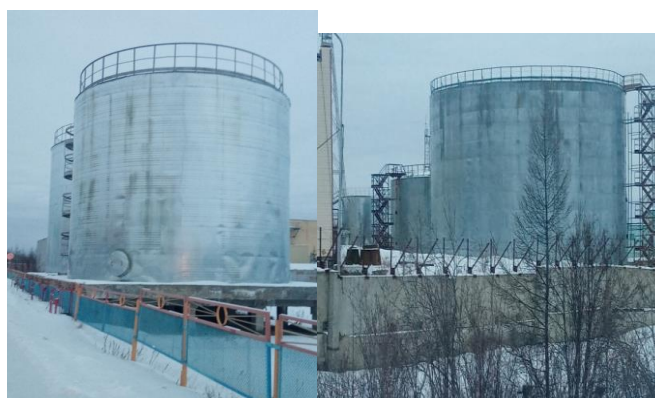
Рис. 17, 18 Резервуары для воды
