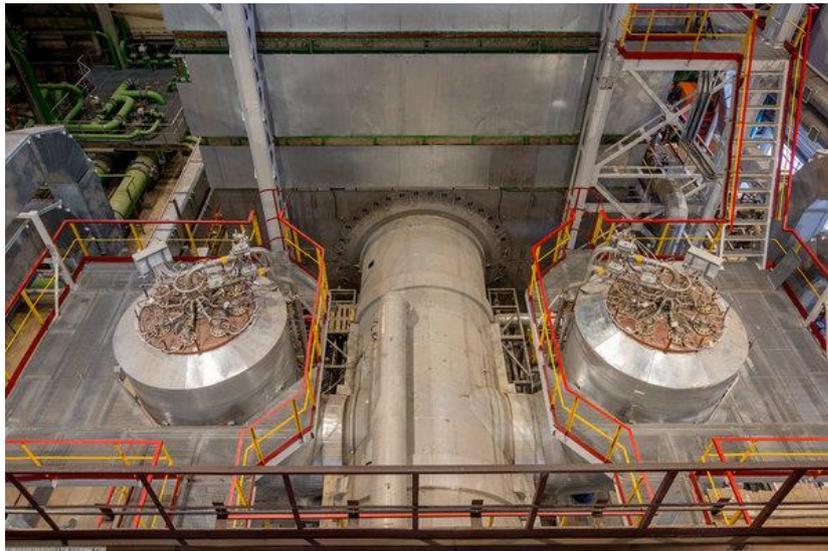
Рисунок 2 – Газотурбинная установка типа ГТЭ-160
