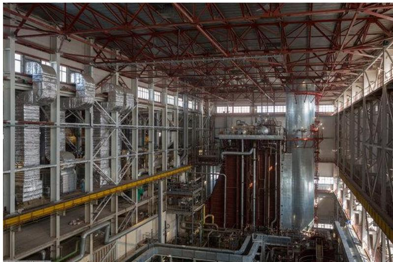
Рисунок 3 – Котел-утилизатор типа Е-220
