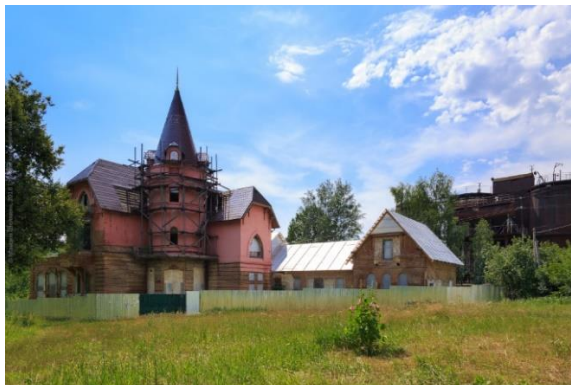
Рисунок 5. Реставрационные работы. Фото 2018 г.
