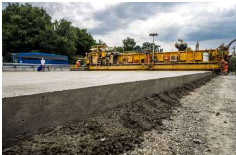
Рисунок 2. Укладка бетонной дороги
