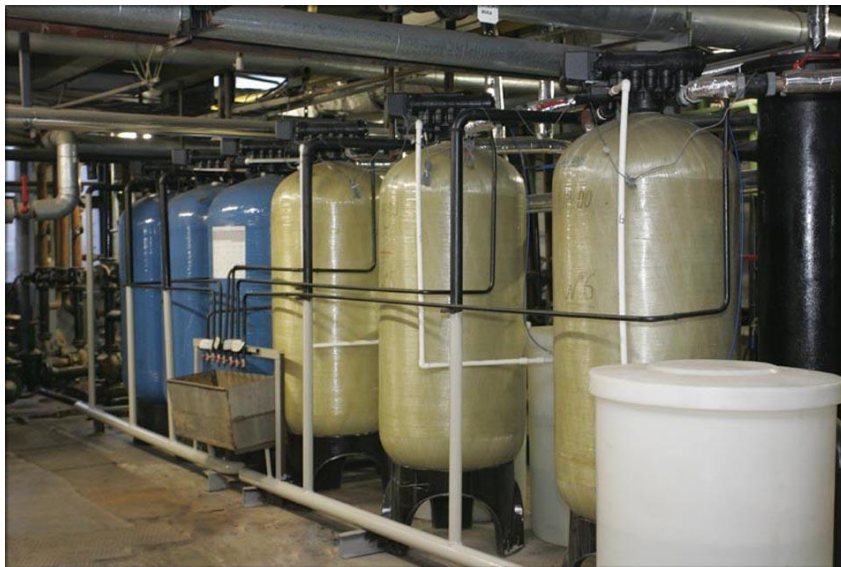
Рисунок 3 – Ионообменные фильтры, используемые на АЭС
