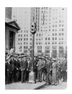
Первые светофоры были механическими с двумя видами сигналов: красным и зеленым. При переключении сигналов светофора издавался звуковой сигнал. В России первая модель светофора была установлена в Ленинграде в
