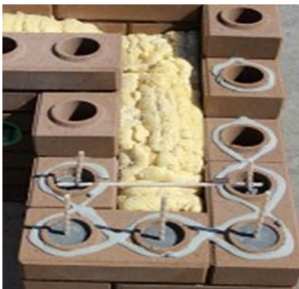
Рис.3. Утепление стены из кирпичей-лего полиуретановой пеной
