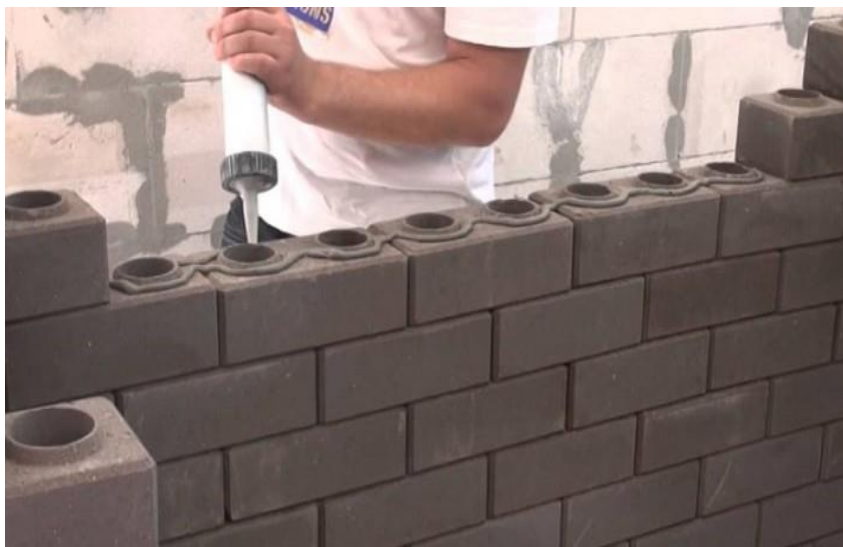
Рис.2. Процесс кладки с применением кирпичей-лего
