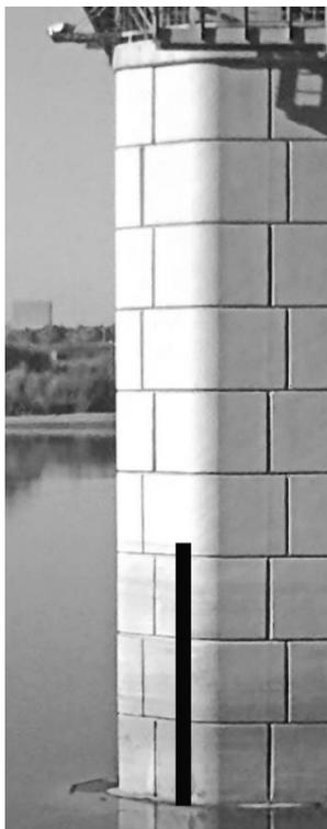
*Рис. 5.* Амплитуда колебаний уровня воды летом 2016 г. (высота черной рейки) составила около 450 см. Высшему уровню соответствовал расход 3400 куб. м в секунду (конец мая), низшему – расход 860 куб. м в секунду (конец сентября). На оригинале снимка видны следы желтого цвета от осевшего на бетон ила
