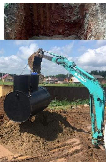
минимум двумя людьми, используя страховочные веревки. Для крепления строп и страх. веревок на СБО есть специальные петли. При опускании исключить резкое падение станции в котлован. СБО устанавливается строго по уровню.
