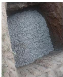
п. 2. На дне котлована делается подушка из гранитного щебня 300-500мм. Колодец должен быть установлен по уровню. Далее подсоединяются трубы и выполняется обратная засыпка песком или грунтом.
