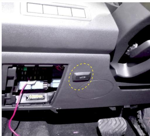
21. Слева от руля выберите место для установки кнопки управления. Используя фрезу 16мм просверлите отверстие. Установите кнопку в сформированное отверстие. Подключите разъем кнопки к разъему кабеля блока управления.
