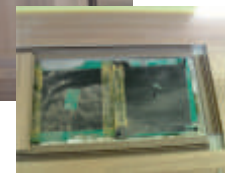
Ремонт системы XL PIPE через монтажную коробку
