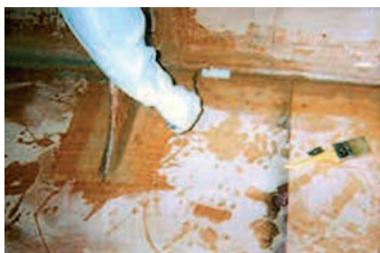
Проклейка стыков "мокрым угольником" требует особой тщательности
