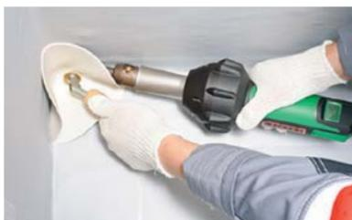
– Проварите радиусы элемента с помощью латунного ролика.
