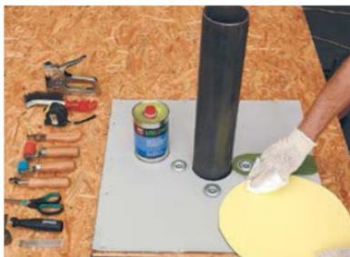
– Вырежьте круглую заготовку из неармированной мембраны **V-SR** (условно показана желтым цветом) таким диаметром, чтобы на **40 мм** перекрывать установленный крепеж.
