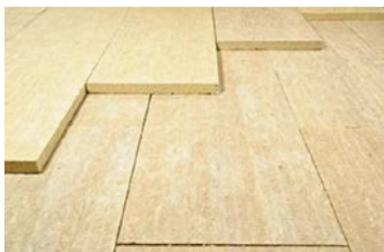
– Если основанием служит профилированный стальной настил, то теплоизоляционную плиту укладывайте длинной стороной поперек гофр профилированного листа.
