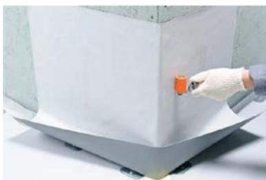
– Приклейте заготовку из мембраны **V-RP** на внешний угол парапета.
