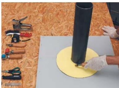
– Не давая заготовке остыть, быстрым движением с силой наденьте ее на трубу и прикатайте основание «юбки» латунным роликом.
