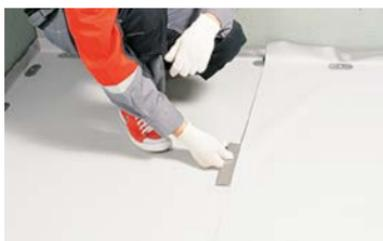
– Извлеките металлические пластины из начала и окончания шва и выполните сварку оставшихся участков вручную.
