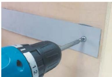
– Закрепите ПВХ планку на вертикали с помощью кровельных саморезов.
