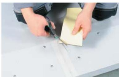
– На зазор наклейте малярный скотч, чтобы предотвратить заваривание зазора ПВХ мембраной.
