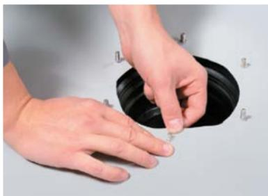
– Возьмите кусок мембраны **V-RP** размером **1x1 м**, приложите к воронке и сделайте надрезы ножом в местах установки шпилек, а затем наденьте мембрану на шпильки.
