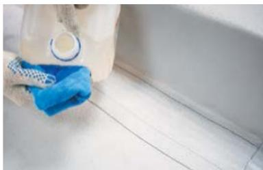
– Перед началом работ по укладке защитного материала LOGICROOF NG удалите с поверхности ПВХ мембраны различный мусор, воду, лед или снег. В случае загрязнения поверхности мембраны или укладки защитного материала на старую мембрану для обеспечения высокого качества сварного шва обработайте места, где будет происходить приваривание защитного материала к мембране, при помощи Очистителя для ПВХ мембран ТЕХНОНИКОЛЬ.
