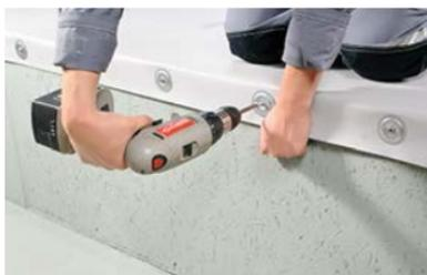
– Закрепите основной кровельный ковер механически, заведя его за карниз. Для крепления используйте металлические шайбы.
