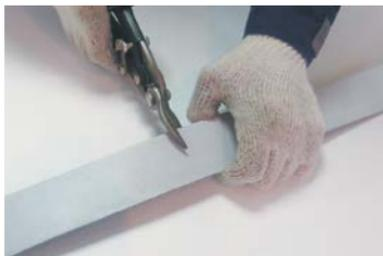
– Для выполнения примыкания к парапету при помощи ПВХ металла нарежьте планки шириной **50 мм** при помощи ручных или электрических ножниц по металлу. Также можно использовать готовые ПВХ планки.
