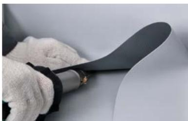
– Для удобства работы прикатайте мембрану вдоль ребер угла латунным роликом и прихватите к основному кровельному ковру с помощью ручного фена.
