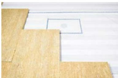
– Монтаж плит теплоизоляции выполняйте на уложенном пароизоляционном слое. Поверхность пароизоляции должна быть сухой.
