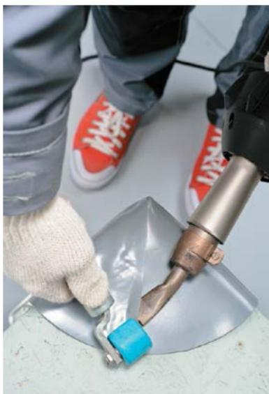
– Выверните деталь наизнанку и проварите шов с внутренней стороны. Проверьте качество сварного шва пробником.
