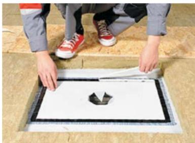
– В случае использования одноуровневой воронки рекомендуется наклеить на пароизоляционную пленку бутил-каучуковую ленту по периметру листа усиления. Плиты XPS во время монтажа площадки плотно прижмите к ленте.
