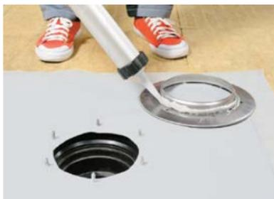
– Для повышения надежности соединения нанесите ПУ герметик на внешний край воронки.
