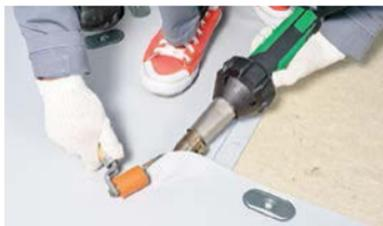
– Приварите угол верхней мембраны к нижнему полотну мембраны. Приварите торец следующего рулона с помощью автоматического оборудования.
