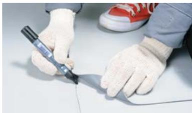
– Закруглите угол на торце верхнего полотна с помощью ножниц. Для удобства отметьте маркером будущий край сварного шва.
