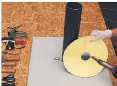
– Нагревайте заготовку с обеих сторон вокруг отверстия с помощью фена до тех пор, пока мембрана не станет пластичной.
