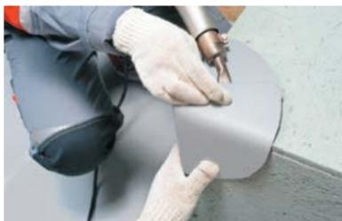
– Соедините радиусы окружности так, чтобы получилась воронка с перехлестом на величину сварного шва (**20 мм**).
