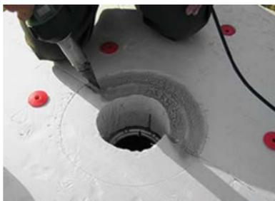
– Сделайте в плитах отверстие для воронки. Для плотного прилегания фланца воронки «снимите» фаску, например, подплавляя XPS с помощью ручного фена.
