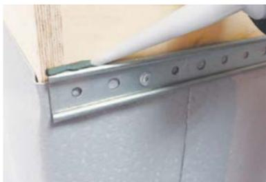
– Срежьте мембрану над краевой рейкой острым ножом и нанесите герметик на отгиб краевой рейки.
