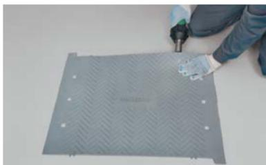
– Зафиксируйте первый элемент дорожки с двух сторон к основному кровельному коврику с помощью ручного фена.
