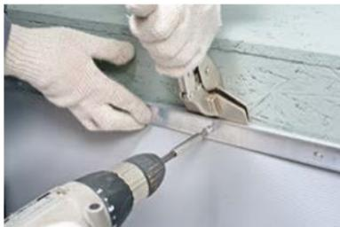
– Для парапетов высотой более **350 мм** используйте завершение с краевой рейкой. Крепите краевую рейку начиная от середины, чтобы можно было равномерно натянуть мембрану по всей длине парапета. Для натяжения мембраны используйте «зажим кровельщика».
