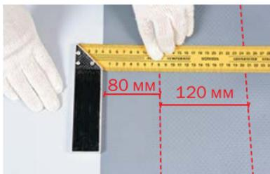
– На изнаночной стороне полосы «парапетной» мембраны нарисуйте линию на расстоянии **80 мм** от нижнего края полотна и по ней выровняйте полосу для «кармана». Для получения «кармана» возможно использование специального готового элемента.
