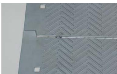
– «Ушки» элементов располагайте таким образом, чтобы они не препятствовали прохождению автоматического сварочного аппарата.
