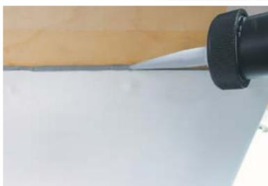
– Для дополнительной герметизации узла нанесите ПУ герметик ТЕХНИКОЛЬ на край планки.
