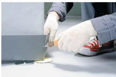
– Разрежьте загиб мембраны в углу кровельным ножом.
