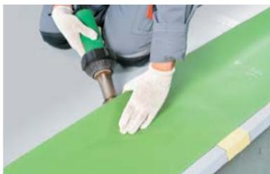
– Точно прихватите ПВХ мембрану к ПВХ металлу, а затем приварите неармированную ПВХ мембрану к капельнику с помощью ручного фена и прикаточного валика. Подрежьте нижнюю выступающую часть неармированной ПВХ мембраны кровельным ножом.
