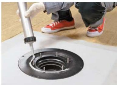
– Для дополнительной герметизации нанесите ПУ герметик по внешнему контуру воронки и замажьте герметиком гайки.
