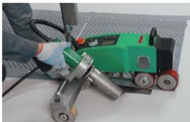
– После сборки пешеходной дорожки в ряд, приварите элементы к мембране, используя автоматическое сварочное оборудование. Для приваривания к кровле предусмотрены специальные полосы без тиснения вдоль краев элемента.
