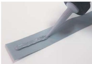
– Нанесите ПУ герметик ТехноНИКОЛЬ строго по центру на внутреннюю сторону ПВХ планки.
