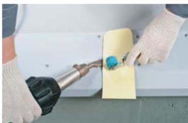
– Вырежьте кусок из неармированной мембраны **V-SR** (условно показана желтым цветом) и закруглите его по углам.
