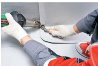
– Приварите все нахлесты. На горизонтали предварительно снимите фаску с края нижней мембраны.
