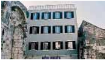
Hotel Peristil Split (Croazia)
