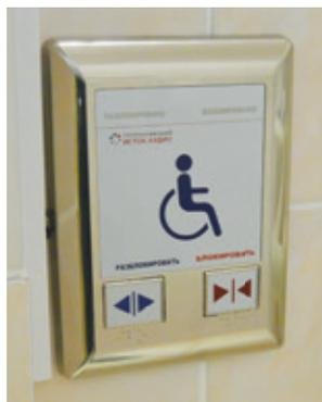
Для обеспечения беспрепятственного доступа в здание и помещения используются автоматические открыватели дверей. Во входной группе идеальным решением являются раздвижные двери. Если такие двери установить невозможно, а также для доступа во внутренние помещения, часто используют автоматические открыватели распашных дверей, не требующие их замены. Питаются от бытовой электросети 220 В.
