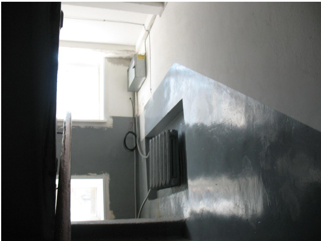
Фото 11 – Фрагмент лестничной клетки в подвале.
