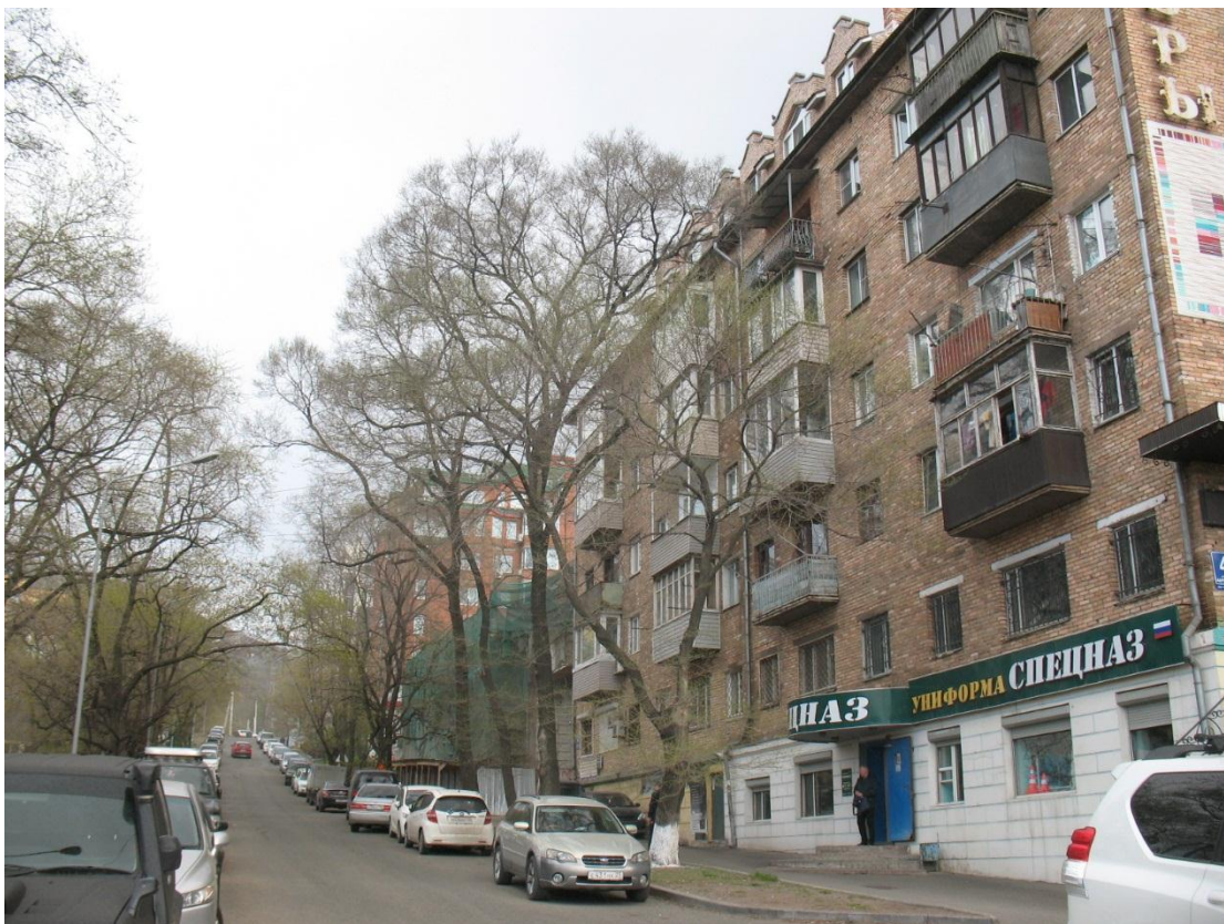
Фото 1 – Общий вид фасада здания. Вид 1;
