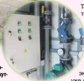
Также в декабре 2019 года была запущена автоматическая модульная котельная «Терморобот - 300», которая обеспечивает теплом здание школы. Котельная представляет собой закрытый утепленный контейнер с бункером для угля и котлами. Одной загрузки бункера объемом 4,2-5 кубических метров хватит на 3-20 суток бесперебойного отопления.
