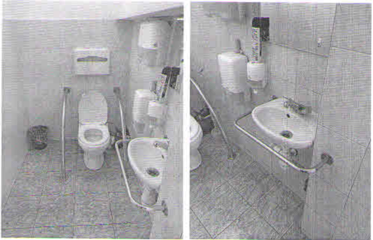
Оборудование существующего санитарного узла для МГН на 1-м этаже
