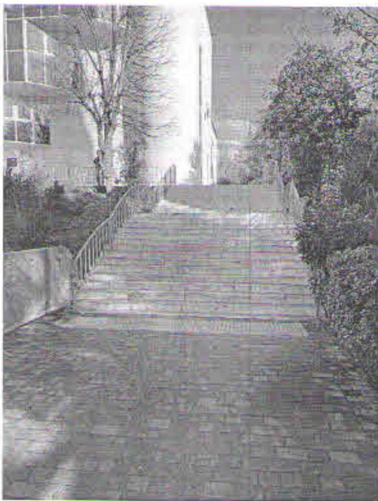
Правая боковая лестница подхода к МБУК ГДК «Юбилейный»
