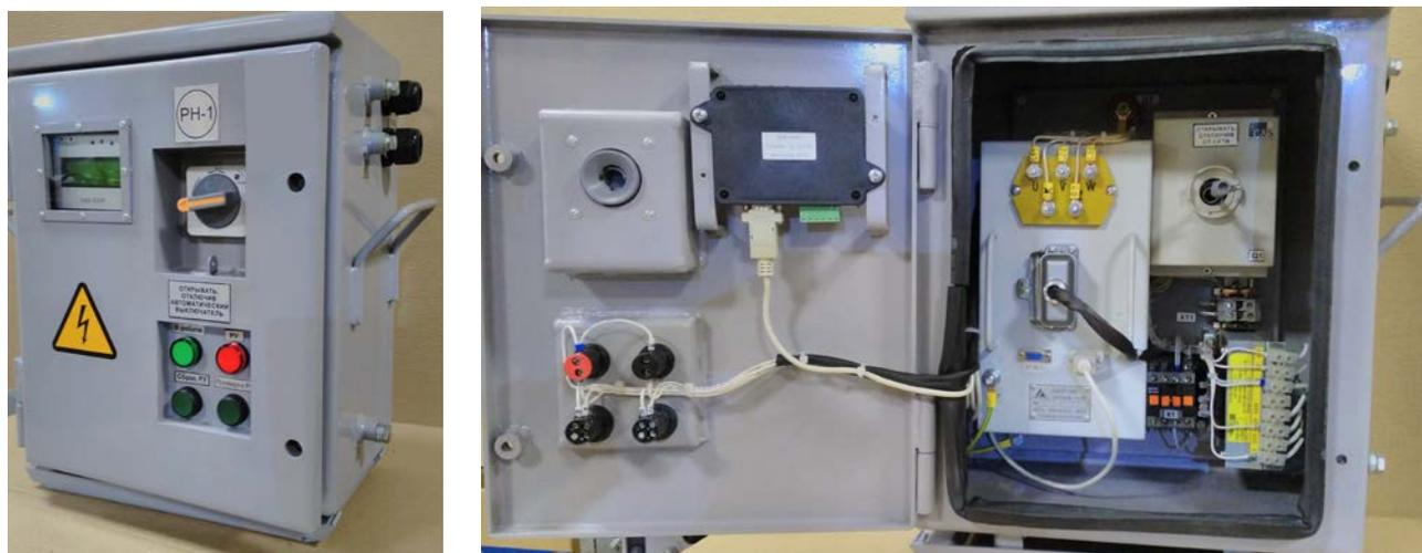
Рис.3 Внешний и внутренний вид аппарата АЗУР-3МКИ
