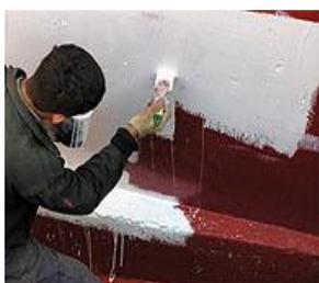
Полная защита и гидроизоляция подземной части помещения включает в себя гидроизоляцию плиты основания и стен фундамента. Правильно выполненная гидроизоляция избавит вас от множества проблем в будущем и продлит жизнь вашего дома.
