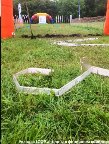
Укладка LOOP антенны в финишном коридоре
