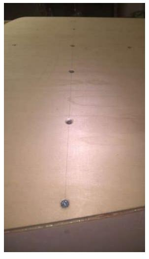
Палуба, банки, пайол кокпита монтируются по схеме ПУР501 + саморезы. Щели и стыки снаружи проклеиваются на слой ленты. Все саморезы снаружи корпуса должны быть утоплены и зашпаклеваны. Поскольку железо разрушает дуб, в дубовом брусе нужно использовать только нержавеющие саморезы; в случае использования оцинкованных, после склейки удалить их и зашпаклевать.
