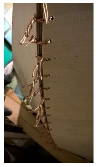
В первую очередь сшиваются между собой детали днища и переборки к днищу. Для сшивания используется медная проволока толщиной 1,5-2 мм с шагом примерно 100-150 мм, в наиболее напряженных участках шаг может быть уменьшен до 30-50 мм.
