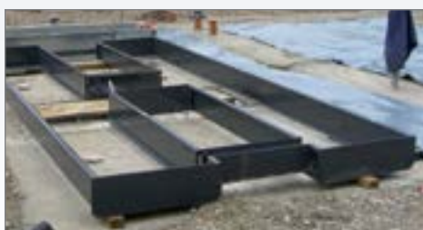
Установочная рама для подъемника с проездными платформами с подъемным полом или без него. Ее использование гарантирует точность монтажа самого подъемника.
