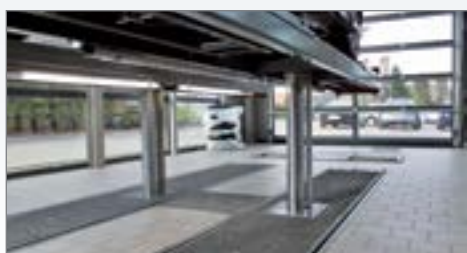
Установочная рама для подъемника с проездными платформами с подъемным полом или без него. Ее использование гарантирует точность монтажа самого подъемника.
