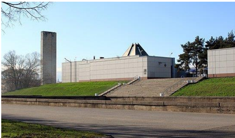
Рисунок 4 - Центральная входная лестница в крематорий Санкт-Петербурга
