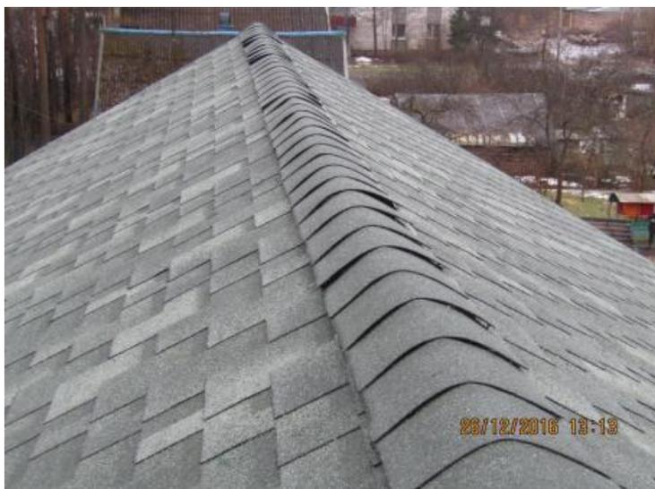
При монтаже коньково-карнизной черепицы при температуре менее +5° необходимо прогреть гонты и предварительно согнуть их на деревянном бруске. После фиксации гонтов гвоздями прогреть самоклеящуюся полосу строительным феном и прижать.
