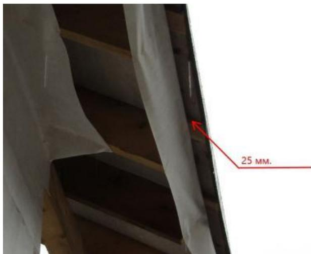
*Вентиляционный канал образован доской высотой 25мм.*
