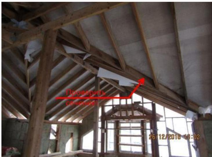
Сечение диагональной наклонной стропилы (в ендове) длиной более 5000 мм. рекомендуется делать не менее 200х100 мм.
