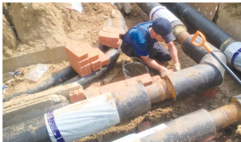
Монтаж новых тепловых сетей
