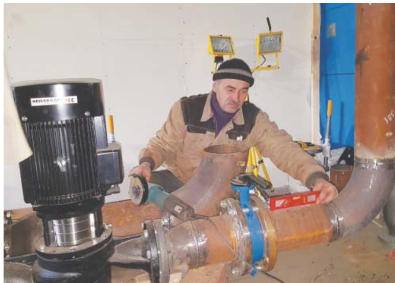
Монтаж модульной котельной Малаховка, Быковское шоссе, 14.1
