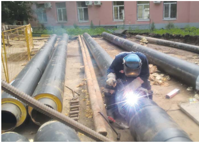
Сварка заготовок магистрального трубопровода
