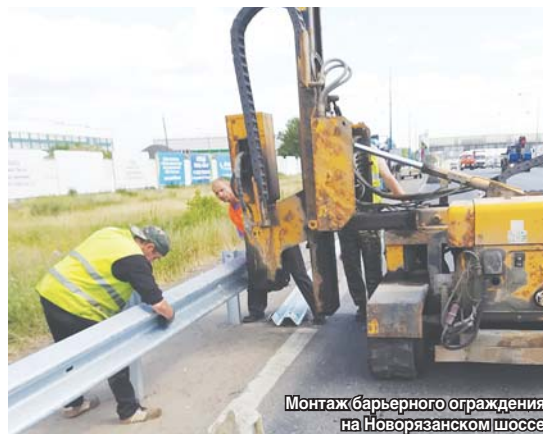
Реконструкция трассы М5 «Урал» идёт полным ходом
