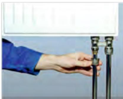
■ (5) С помощью резьбового соединения евроконус 15-3/4 присоединить трубку к узлу подключения
