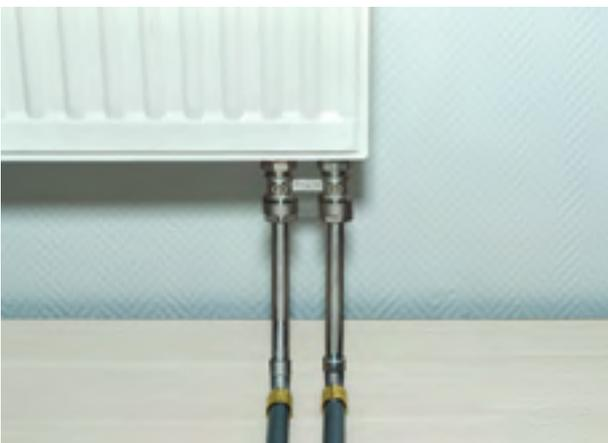
Присоединение никелированных трубок выполняется посредством зажимного соединения на запорный узел радиатора.
