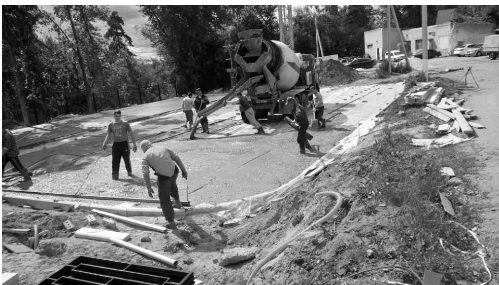
Завершение работ в школе №10. Июль 2020 г.
