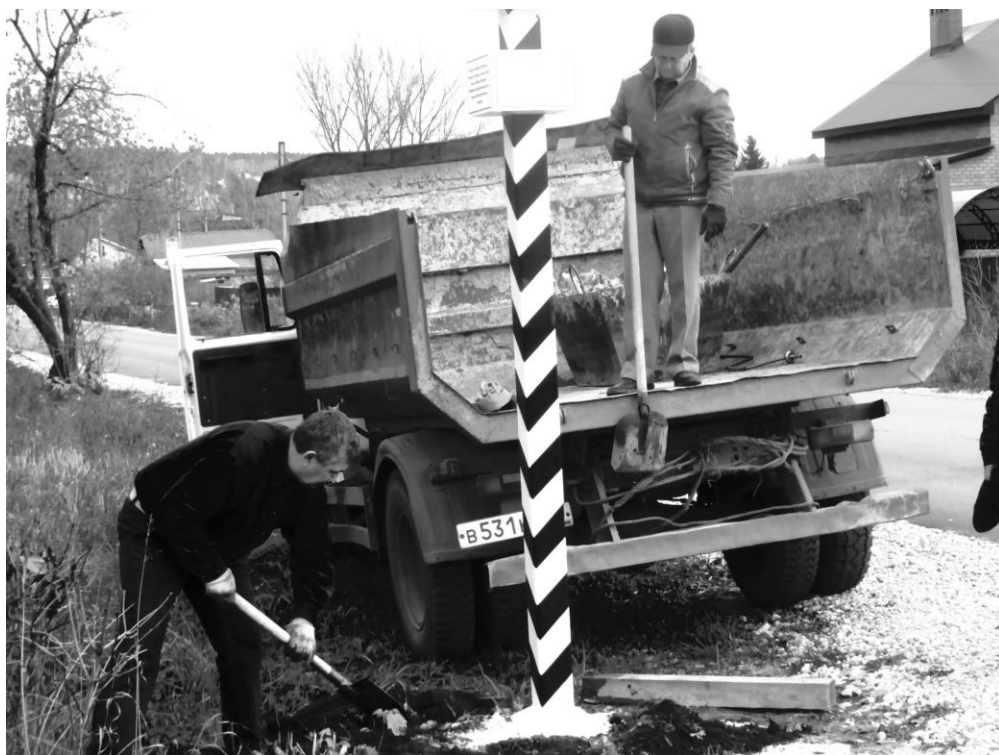
Установка Верстового столба
