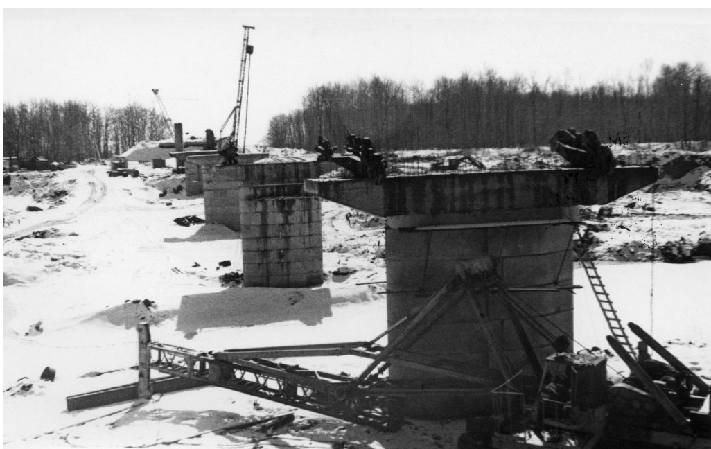
Этапы строительства моста
