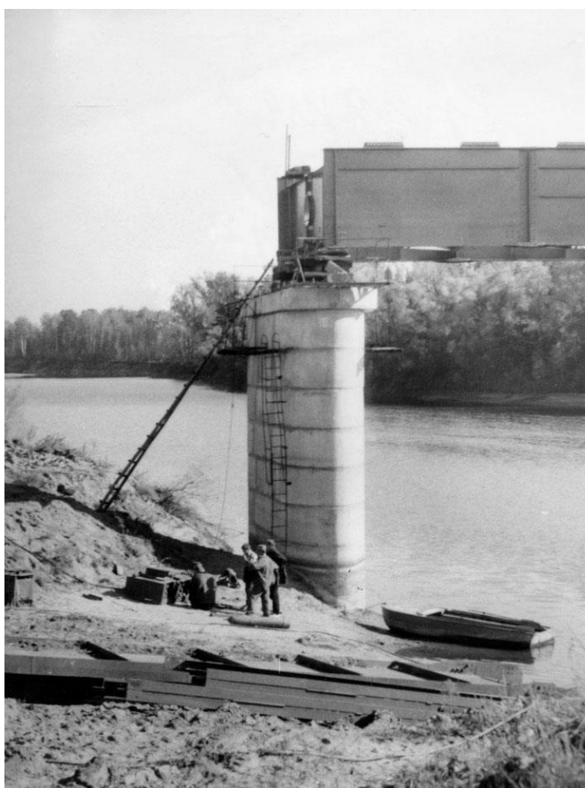
Этап строительства моста
