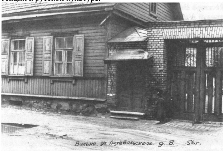
Дом Александра Гизелевского на ул. Пшевальского (Вивульского) в Вильно - его "последний адрес". Не сохр.
