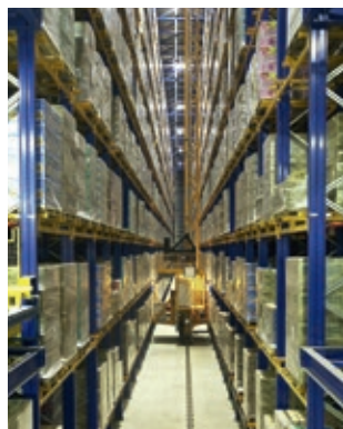
为定位堆垛起重机提供导引
